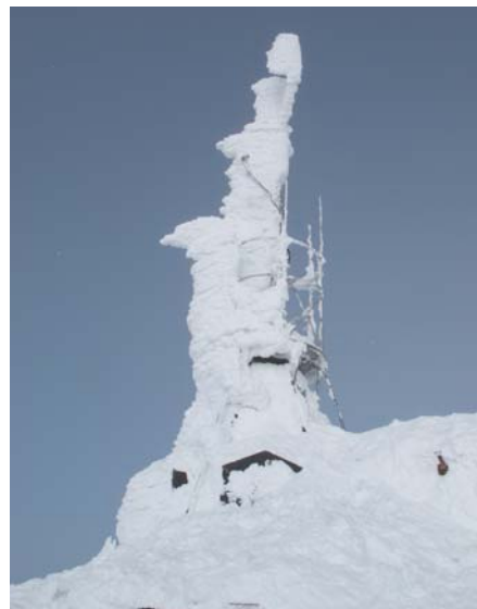
Messstation Säntis im Rauhreifpanzer. Foto: Giovanni Converso, 26. 01. 2012.
