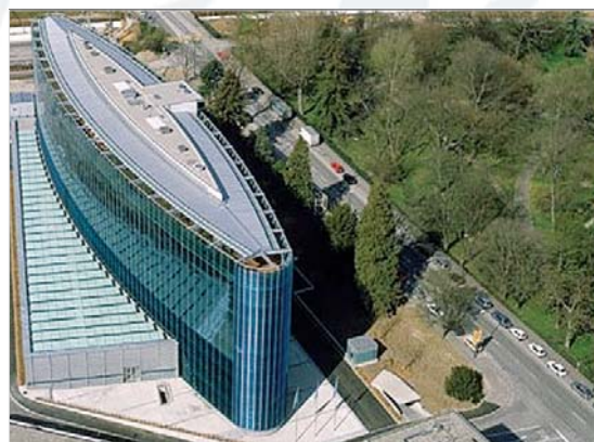
▲ Le bâtiment de l'OMM à Genève
